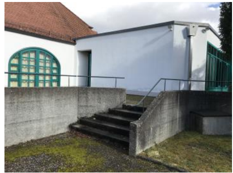
Schneefanggitter auf dem Dach des Pfarrstadels, sowie Geländer auf der Südseite des Pfarrzentrums.
